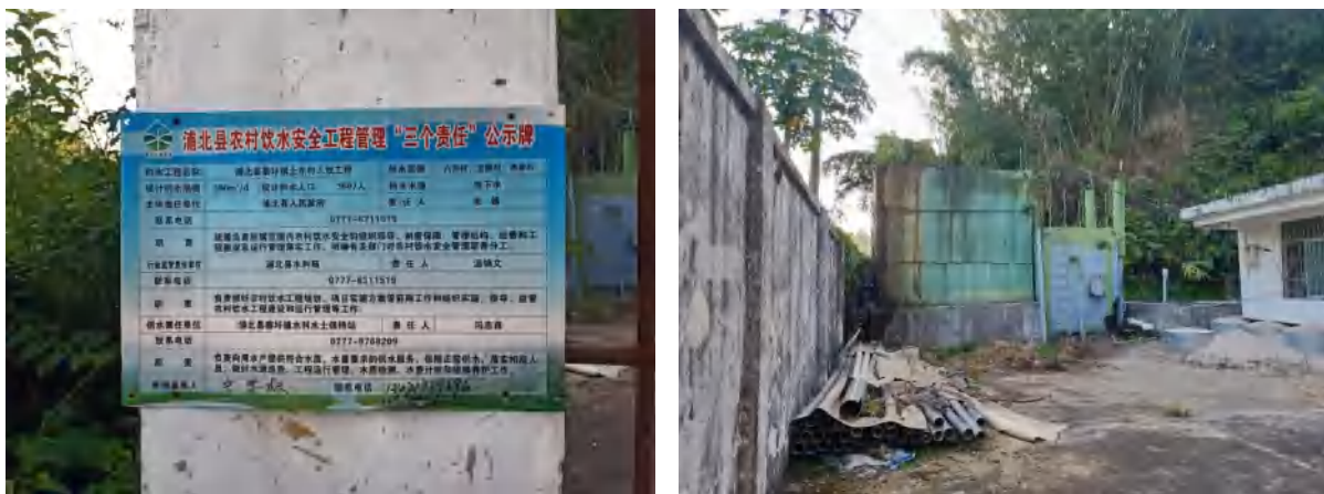
图 4.2.3-3 寨圩镇土东村人饮工程实景图
