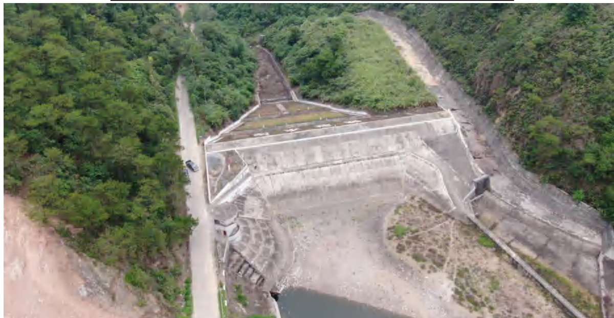
图 4.6.7-7 铁联水库主坝实景图
