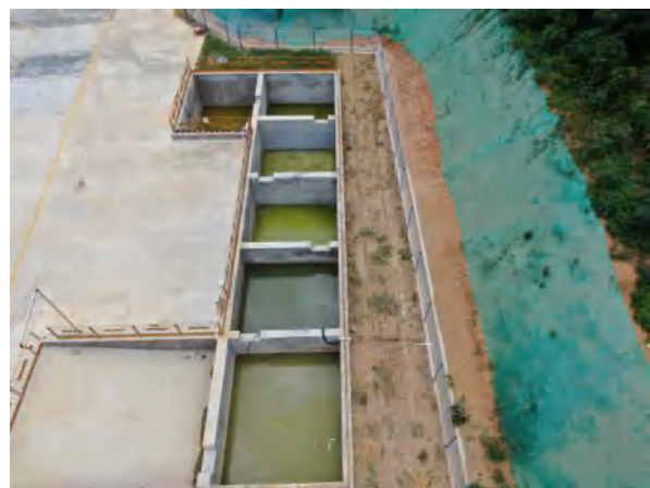
场地内沉淀池及室外边坡防护
