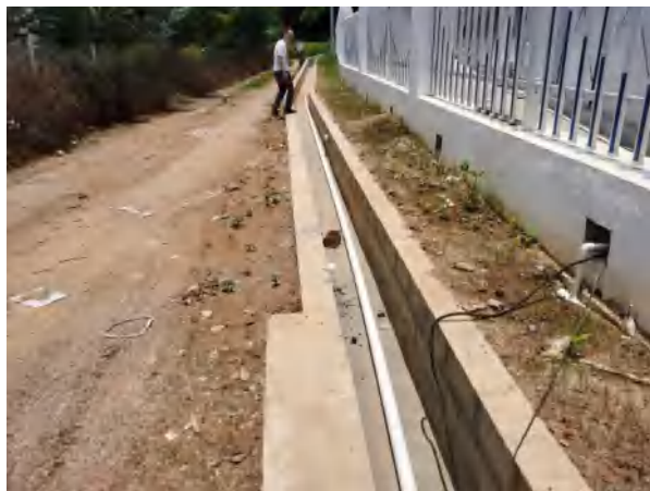
室外截排水沟
