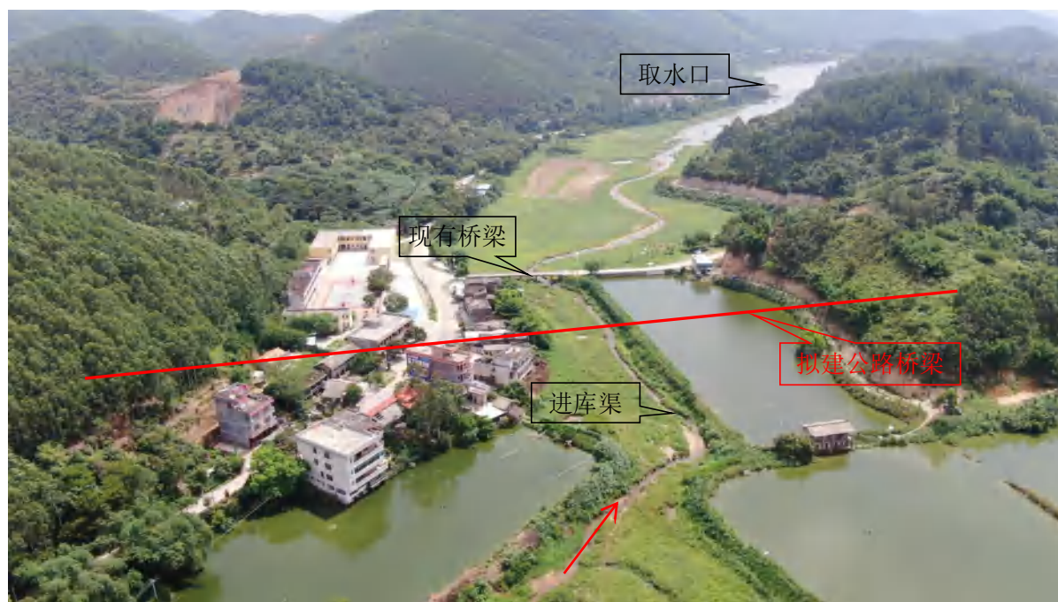
图 4.6.7-5 现有库尾桥梁实景图
